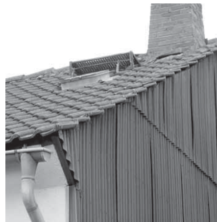
Bitumenplatten werden durch Wärmedämmputz ersetzt.
