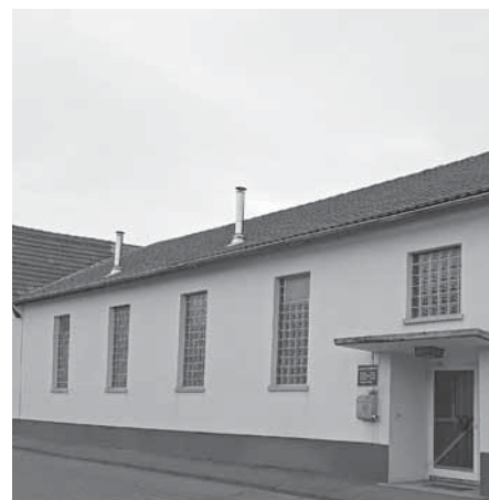
Aus Glasbausteinen werden Wärmedämm- und Schallschutzfenster.
