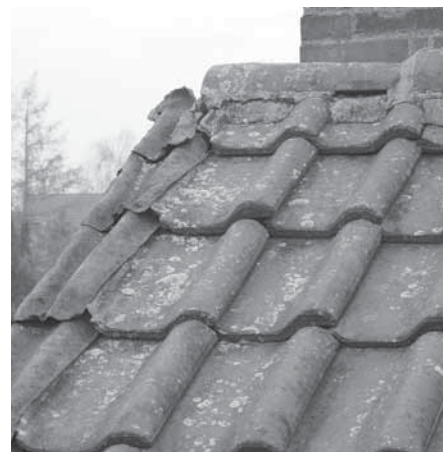
Marode Ziegel werden neu eingedeckt.
