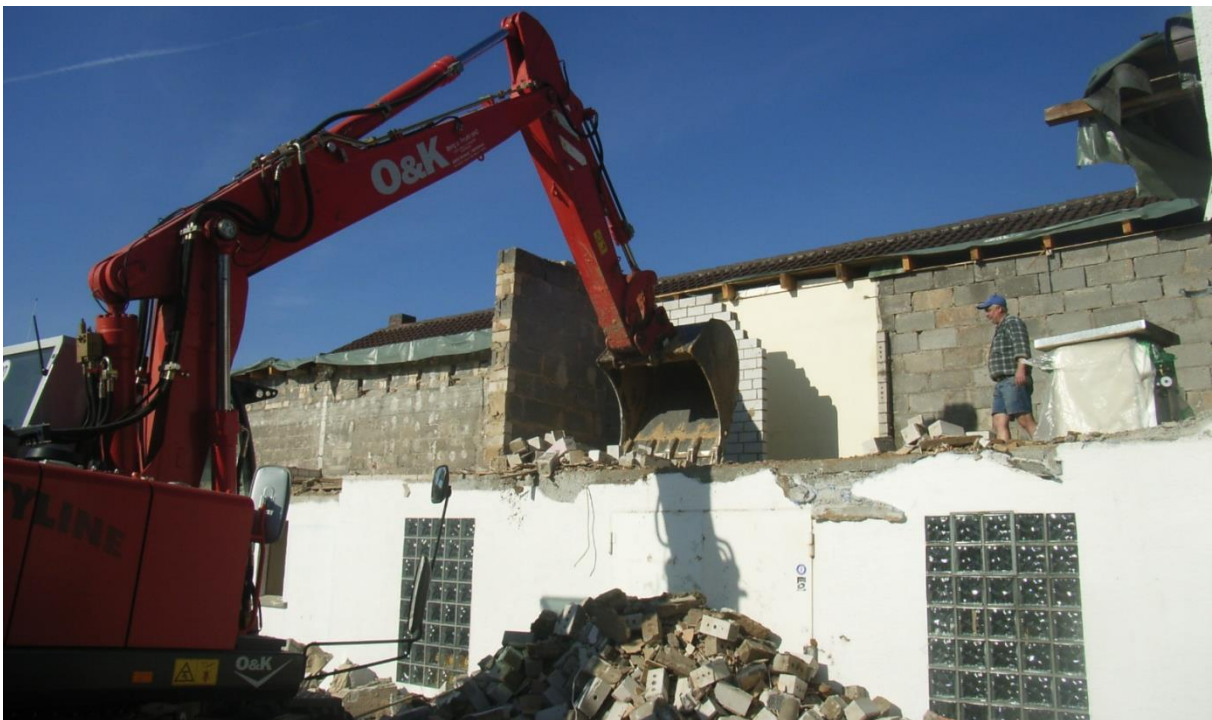
Abbildung 75: Ein Teil des Obergeschosses über dem Eingangsbereich und den Wirtschaftsräumen wird abgerissen.
