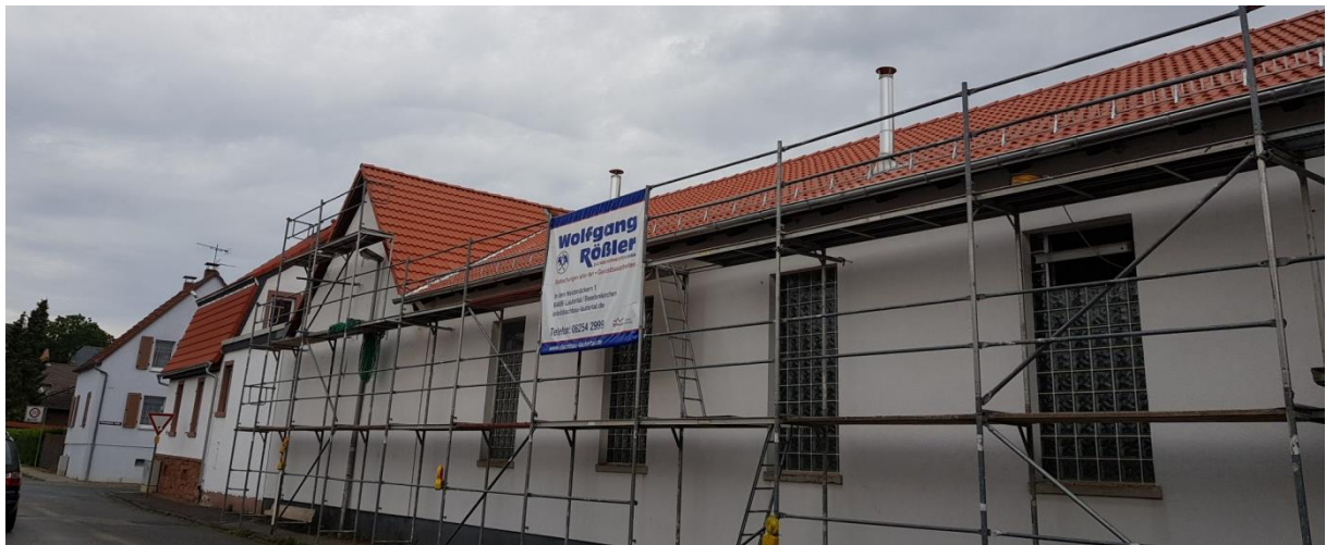
Abbildung 102: Das neue Dach ist schon gedeckt, während die Fenster noch ausgetauscht werden müssen.
