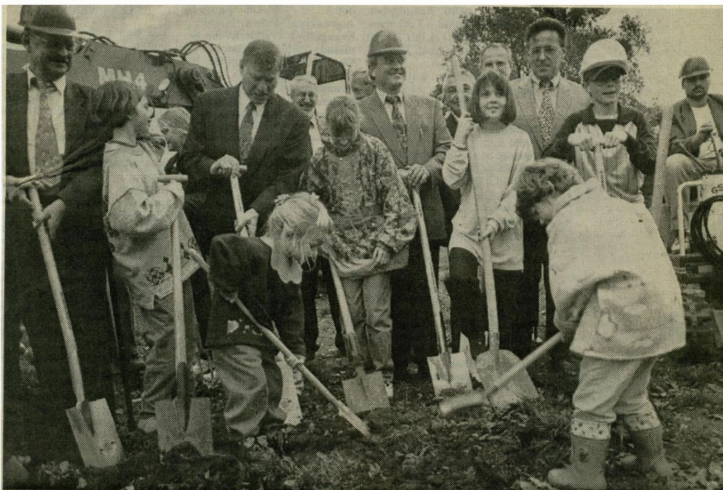
Abbildung 45: Erster Spatenstich für die neue Sporthalle, die Jugend legt fleißig mit Hand an.
