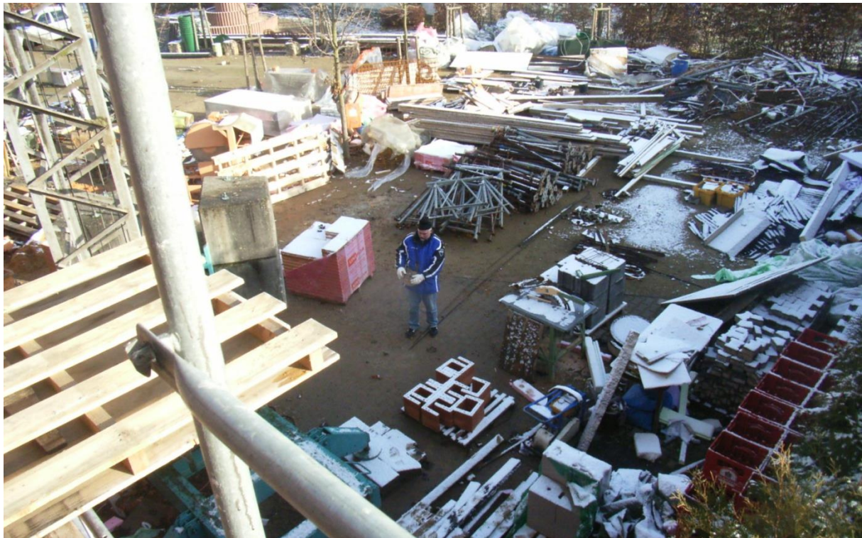
Abbildung 76: Im Herbst 2008 gleicht das Freigelände neben der Turnhalle einem großen Baulager.
